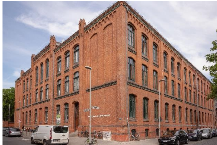
Schulgebäude – Ecke Davenstedter Straße / Küchengartenstraße
