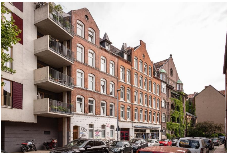
Großstädtische Mietshäuser / Davenstedter Straße 6 - 10
