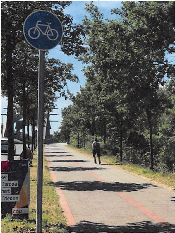
Radweg Eulenkamp, Rampe Brücke Mittellandkanal, Richtung Süden:
