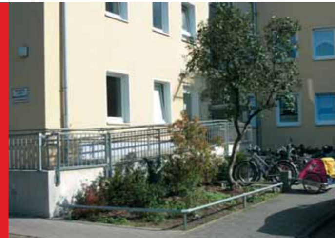
AM BAUTZENER HOF FÜHRT EINE RAMPE ZU BEHINDERTENGERECHTEN WOHNUNGEN.
