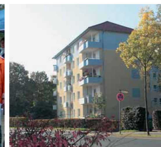
DER ZITTAUER HOF GEHÖRT ZU DEN WICHTIGEN SANIERUNGSPROJEKTEN.
