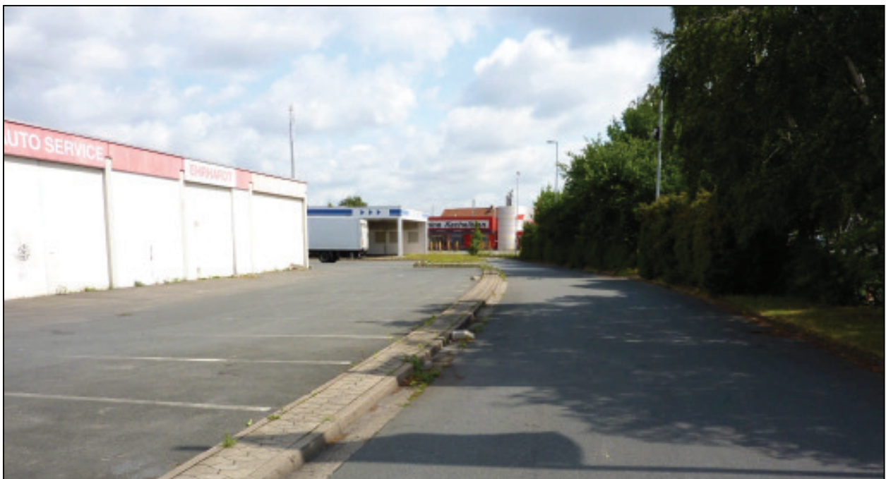
Abb. A-6: Rückseite von zwei der drei Gebäude am Ostrand des Gebietes als Beispiel für ein bauartbedingtes geringes Quartierpotenzial für Fledermäuse; potenzielle Spalten könnten im Übergang zu den Dächern vorhanden sein.
