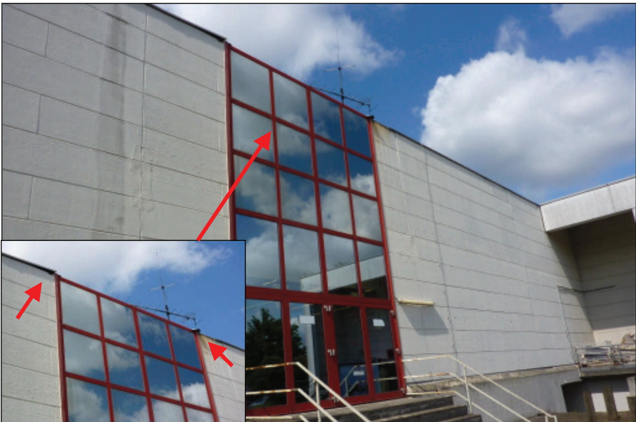
Abb. A-4: Beispiel für bautechnisch bedingte Spalten und Öffnungen der Fassadenverkleidung im Übergang zum Dach, welche einzelnen Fledermäusen als Tagverstecke dienen können.
