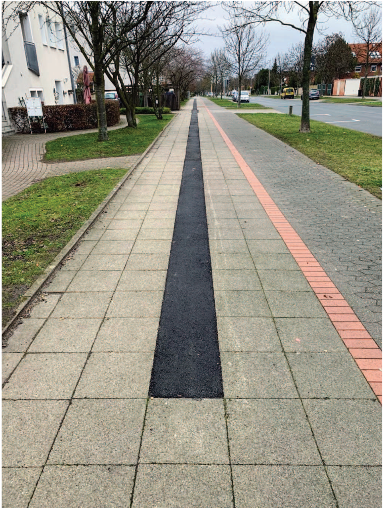
Derzeitiger Zustand des Fußweges nach Verlegung der Erdkabel
