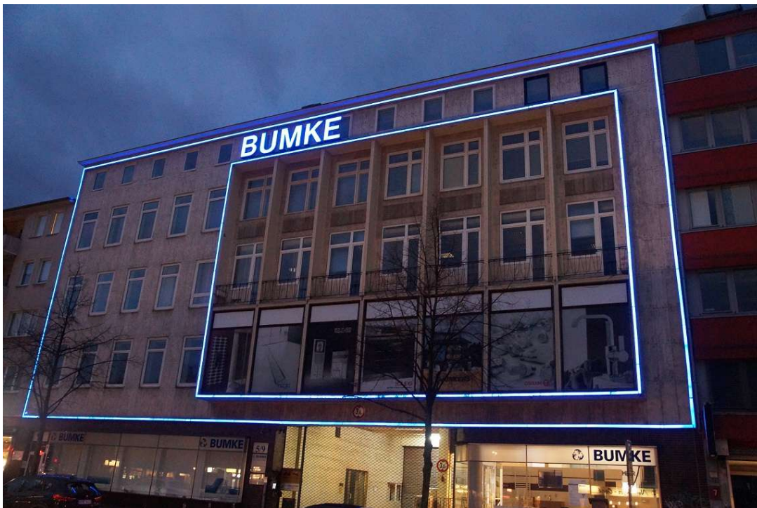
Abb.: Ansicht auf das Bumke-Haus vom E-Damm aus
