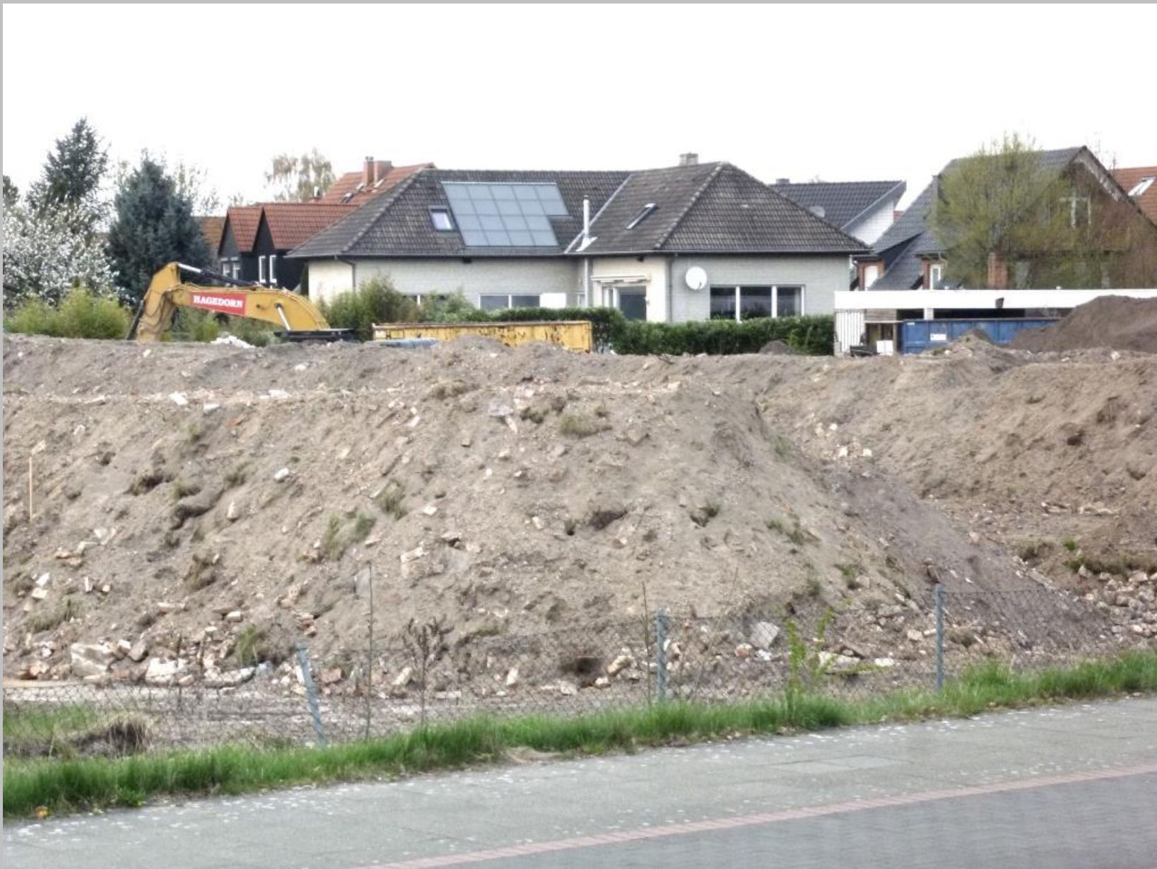
Bodensanierung: Beseitigung von Schuttauffüllungen
