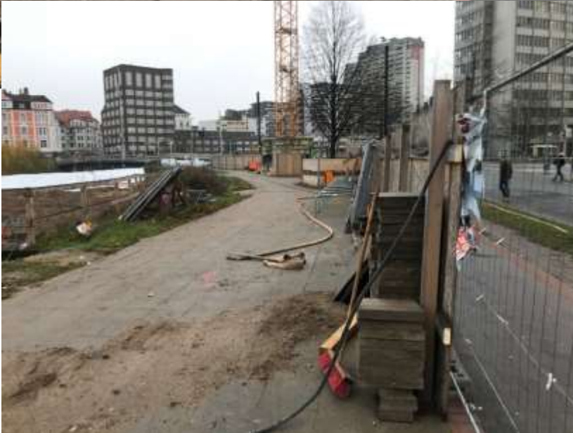
derzeitiger Zustand Ohestraße und Vorplatz
