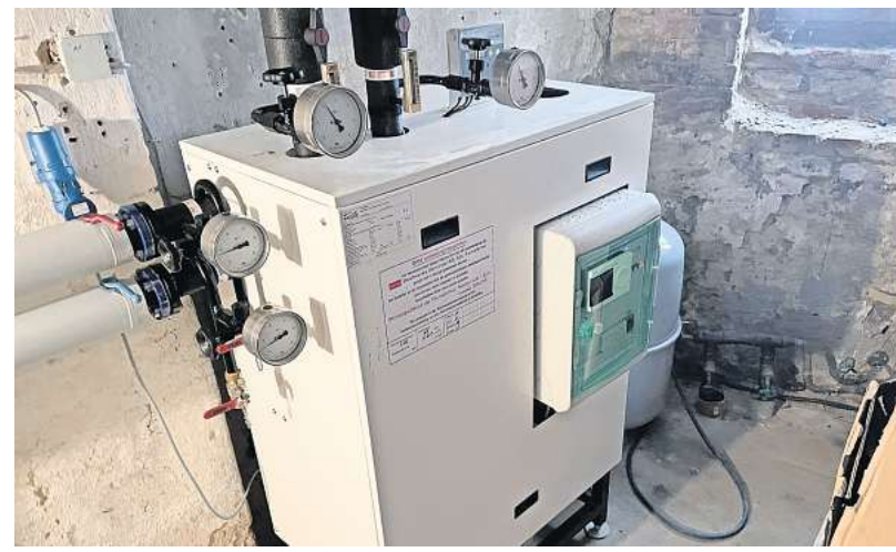
Umbau abgeschlossen: Eine neu eingebaute Fernwärmeübergabestation im Keller eines Mehrfamilienhauses in Hannover.
