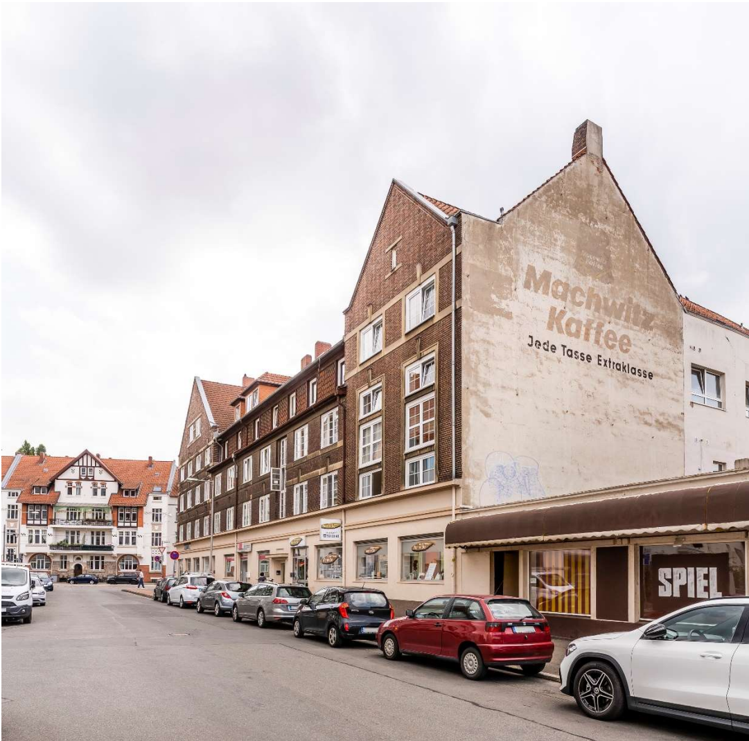
Abb. 12: Breithauptstr. 1 bis 3, Schließung des Blockrandes bis zur Kirchröder Str., Foto LHH Bereich Geoinformation.
