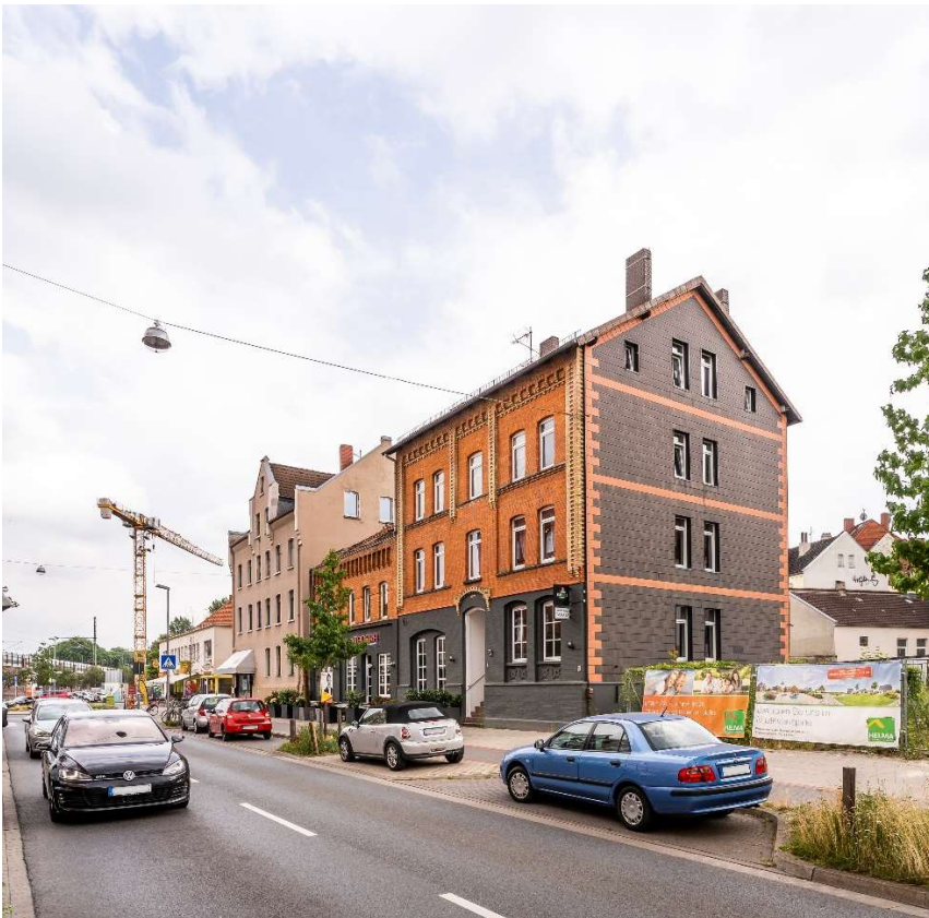
Abb. 10: Scheidestr. 20 und 22, Blickrichtung Osten, Foto LHH Bereich Geoinformation.
