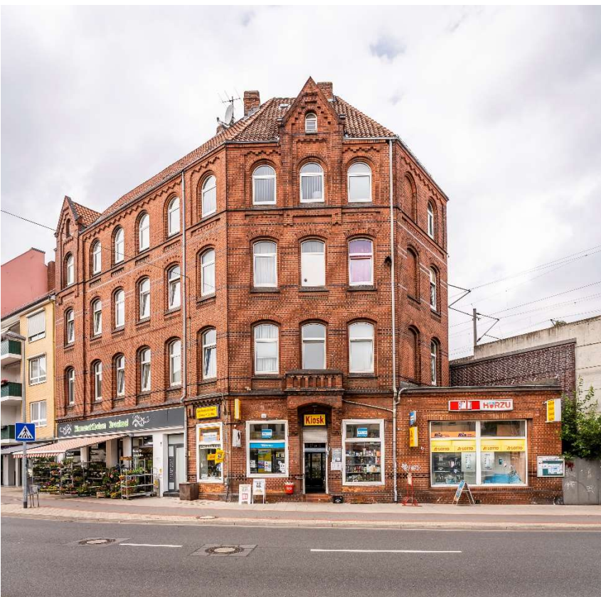
Abb. 8: Scheidestr. 35, Abschluss des Blockrandes zum Bahndam mit Eckbetonung, Foto LHH Bereich Geoinformation.
