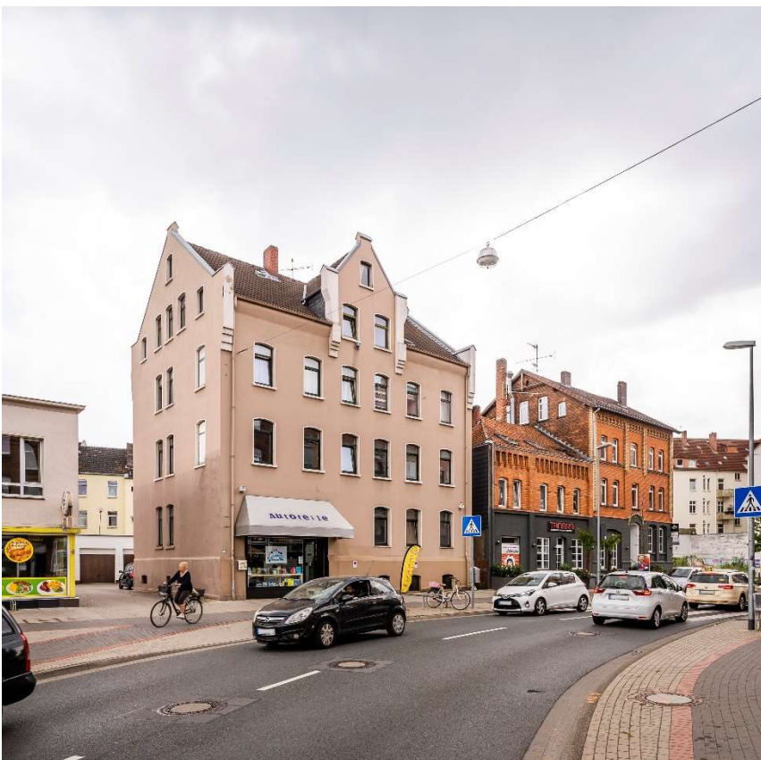
Abb. 11: Scheidestr. 22 und 20, Blickrichtung Westen, Foto LHH Bereich Geoinformation.
