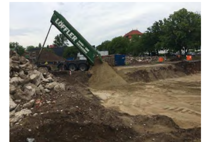
Abtrag bis gewachsener Boden
