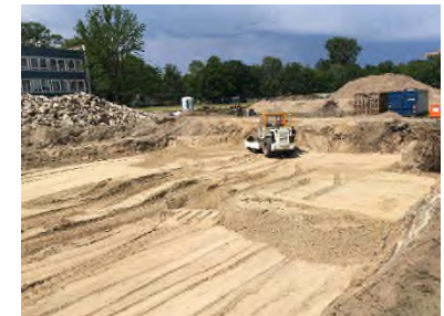
Verfüllung und Verdichtung
