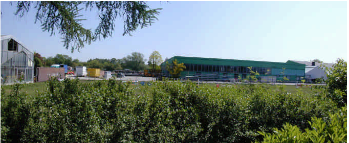
Foto 4: Blick von Westen auf die Rückseite des Garten-Centers Meisert (links im Neubau bzw. Umbau befindliche Gebäude auf dem Privatgelände Meisert)
