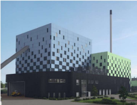
Abb. 2: Biomasseheizkraftwerk in Hannover-Stöcken (nach Fertigstellung)
