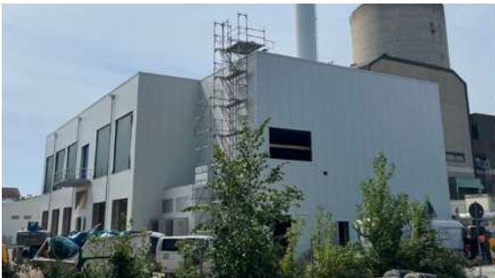
Abb. 3: Hochflexibles Biomethan-Blockheizkraftwerk in Hannover-Herrenhausen
