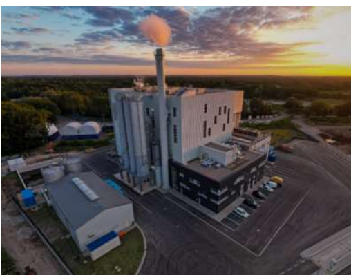
Abb. 1: Klärschlammverwertungsanlage in Hannover-Lahe
