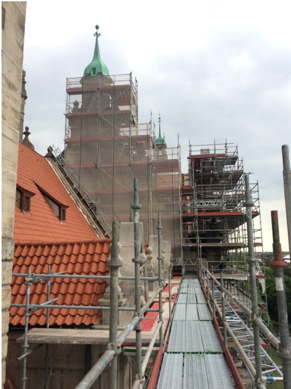
Gerüstansicht in Höhe der Traufe
