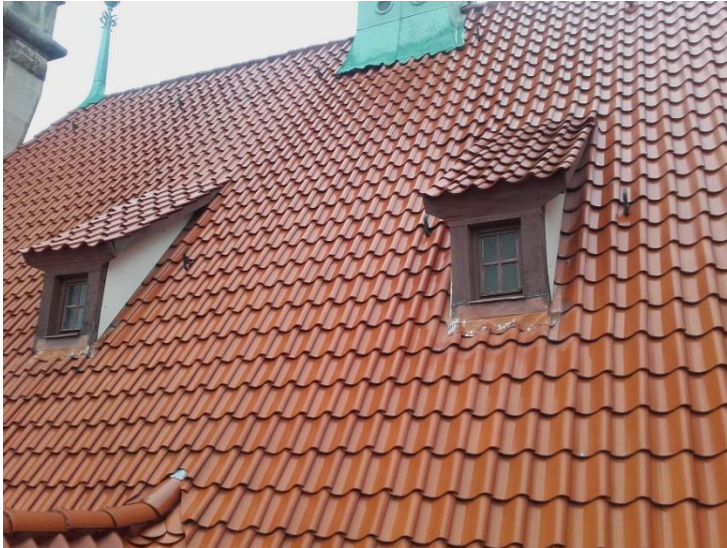
Zustand der Dachgauben vor der Sanierung
