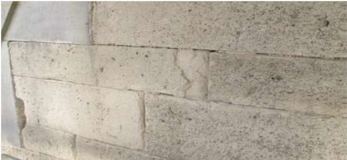
Ansicht der Tuffsteingiebel vor der Sanierung
