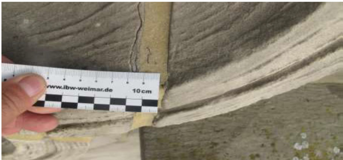
Flankenabriss Polymerfuge
