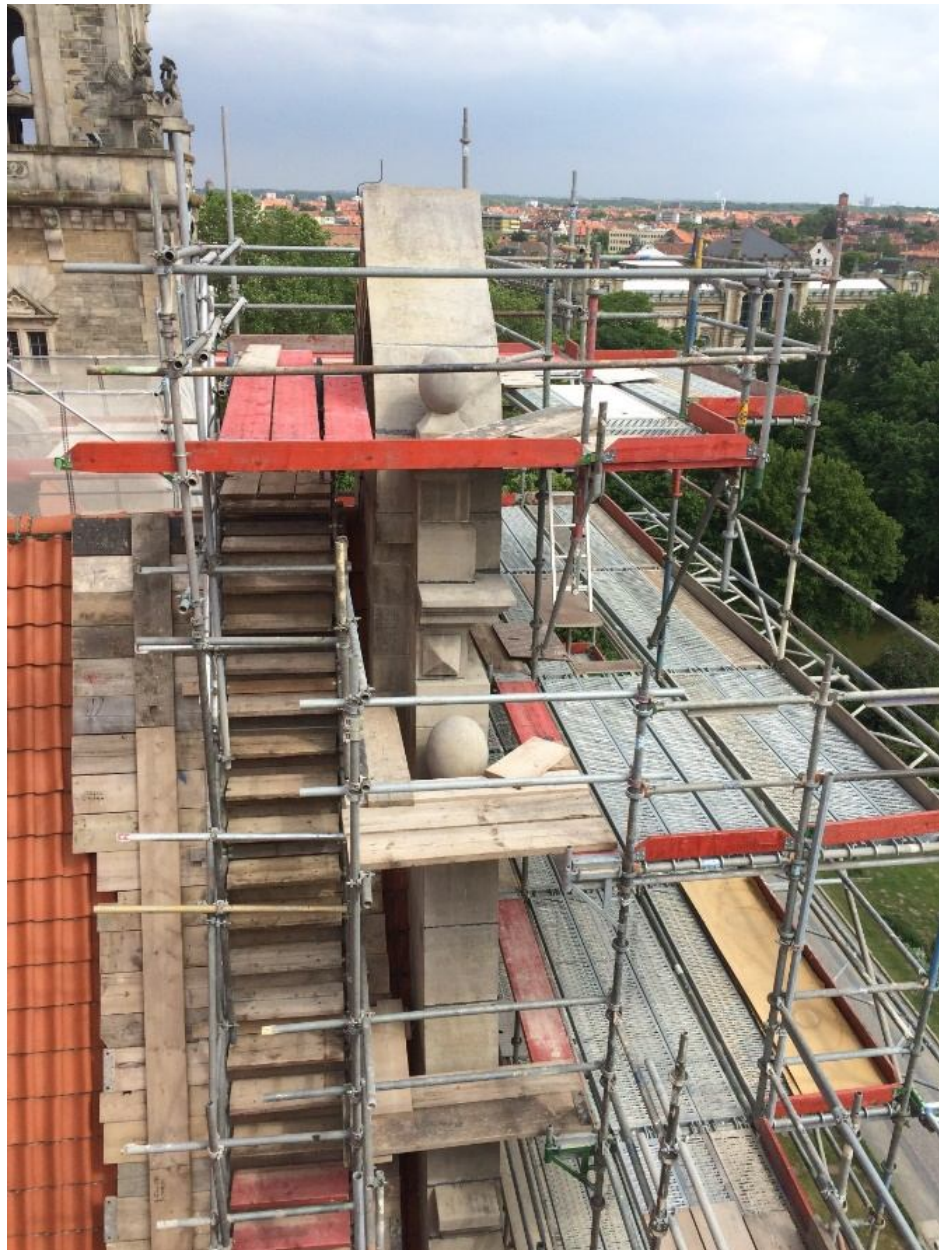
Gerüstansicht im Bereich der Schweifgiebel Doppelte Gerüsttiefe aufgrund von Vor- und Rücksprüngen der Fassade
