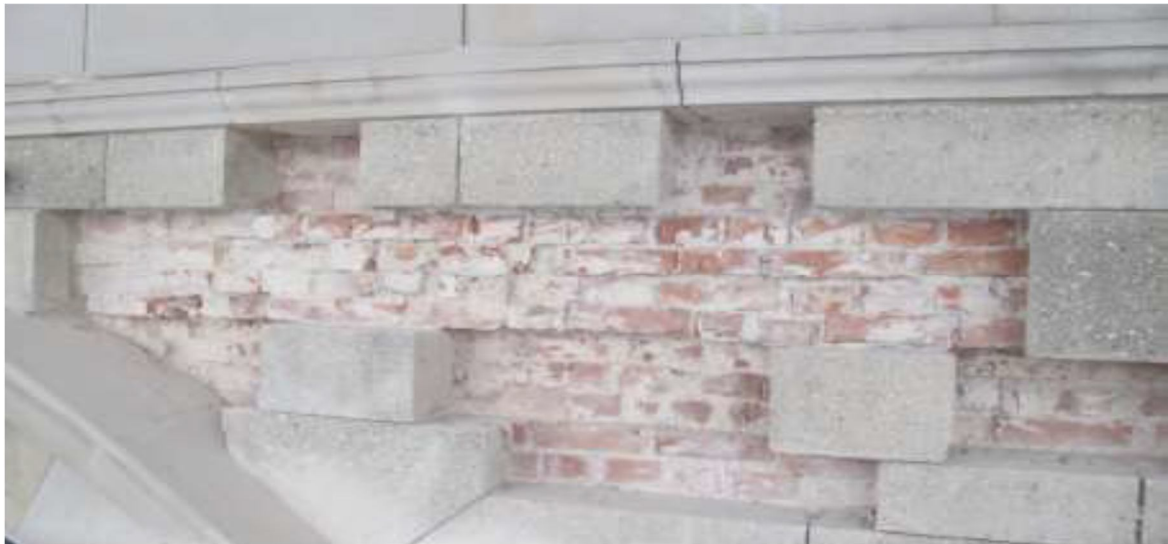
Wände Bereich Gartensaal
