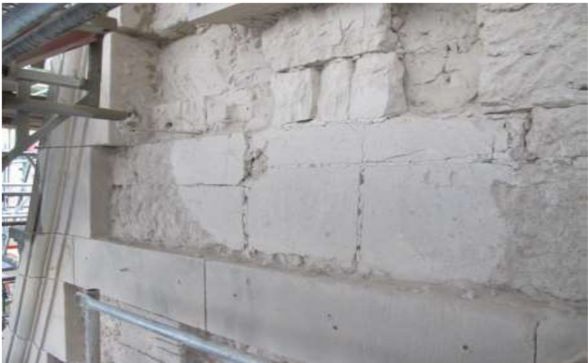
Rückbau der geschädigten Bereiche
