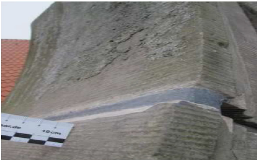
Instandsetzung / Feuchteschutz durch Bleifuge
