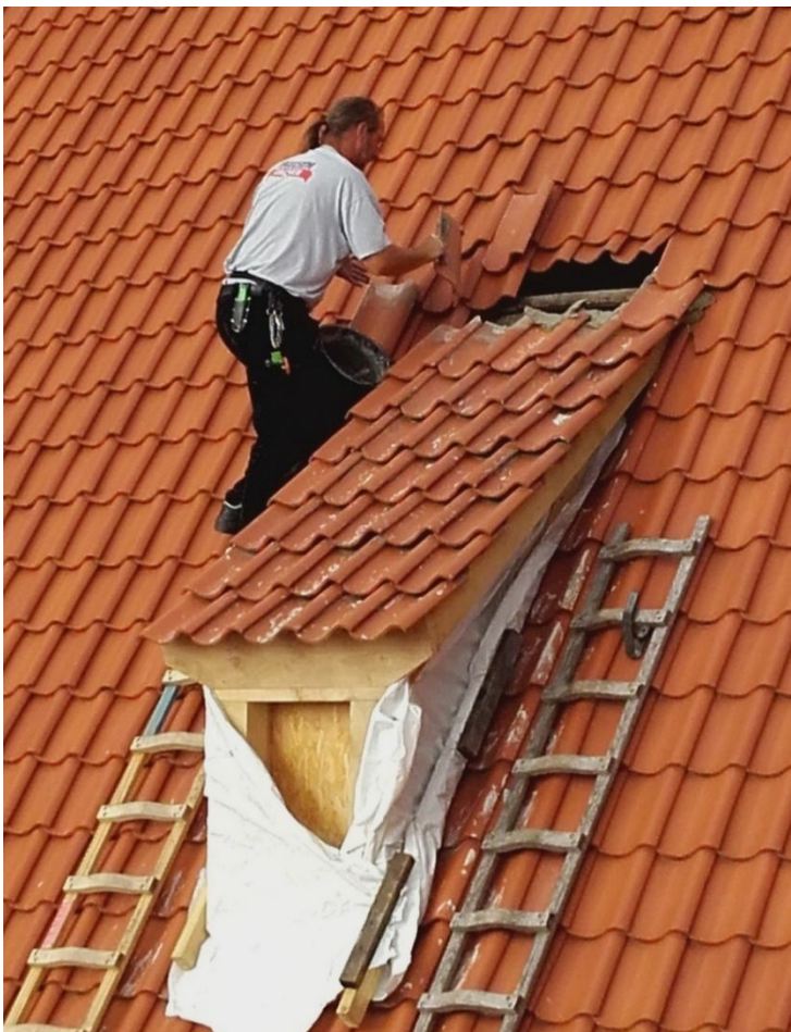
Erneuerung der Dachgauben
