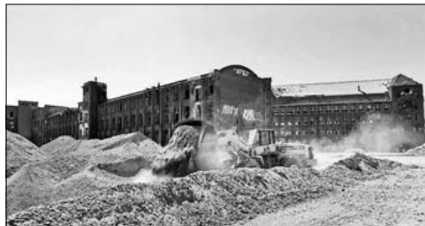
Staubiger Job: Derzeit verfüllen Radlader Baugruben auf dem Gelände.
