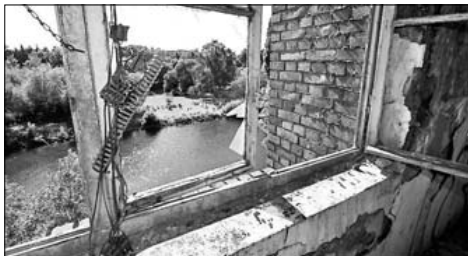
Blick ins Grüne, aber nicht mehr lange: Gebäude 44 muss dem Kanalausbau weichen.
