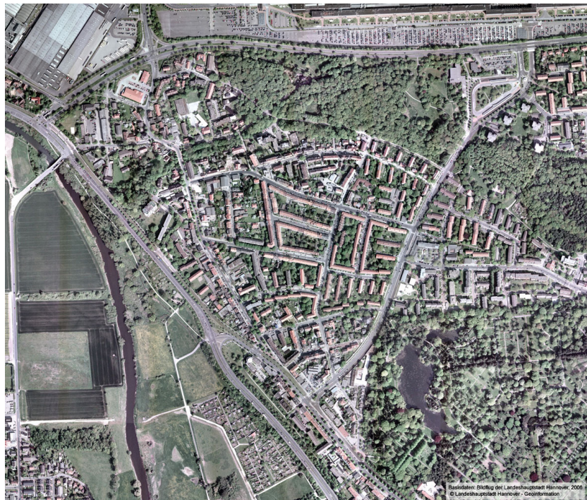
Luftbild Sanierungsgebiet Stöcken
