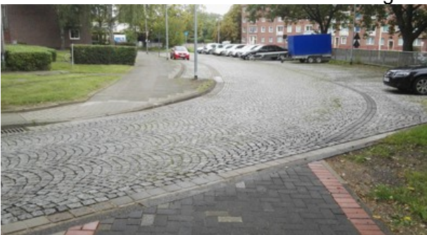
Am Göttinger Hof führt der Fahrradweg in einer Flucht auf den Fußweg der gegenüberliegenden Straßenseite bzw. unkontrolliert auf die Autostraße
