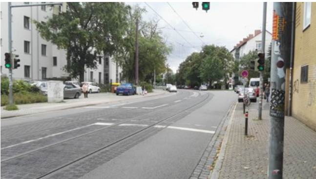
In der nördlichen Ricklingerstraße fehlen Fahrradwege
