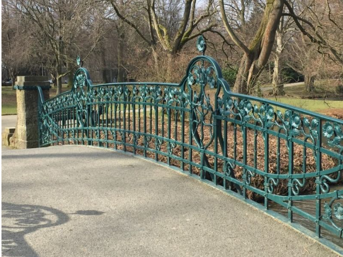
Geländer der Brücke Maschteich
