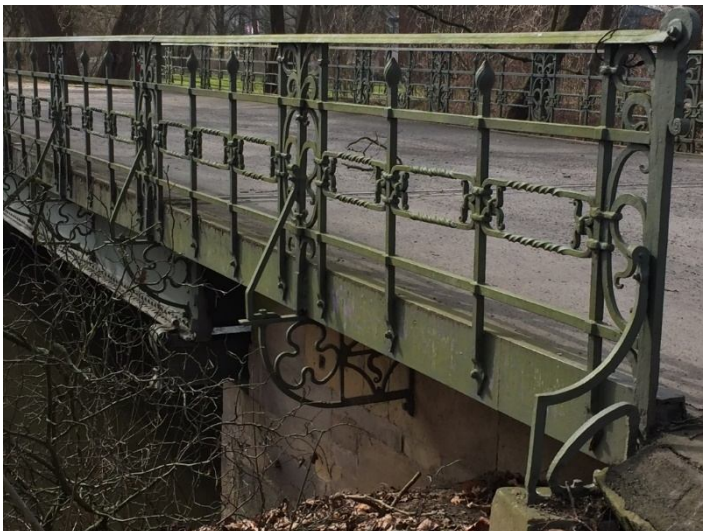
Geländer der Brücke bei „Loretta“
