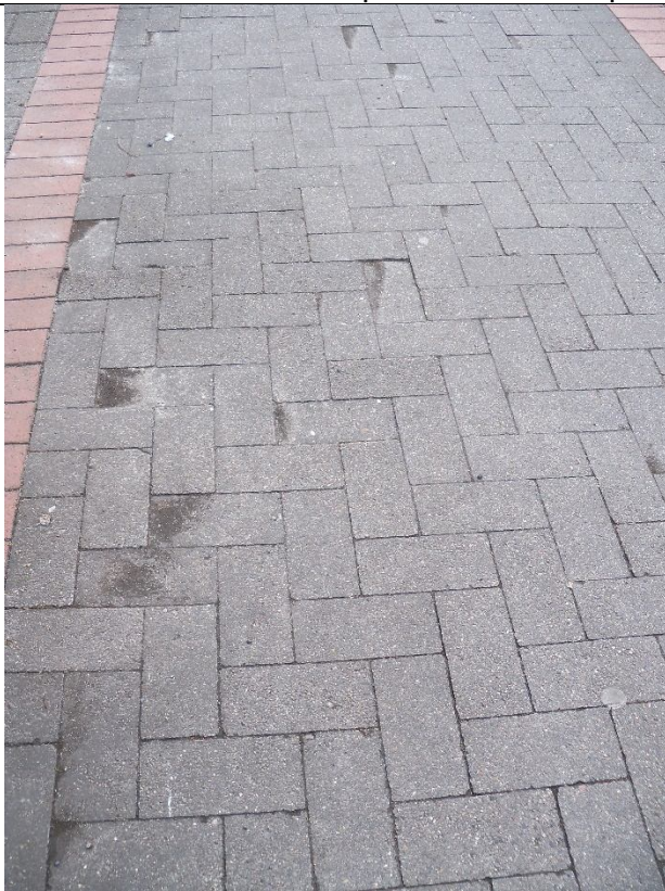
Radweg Geveker Kamp gegenüber TUS Davenstedt – Zustand etwa 10 Jahre nach Grunderneuerung
