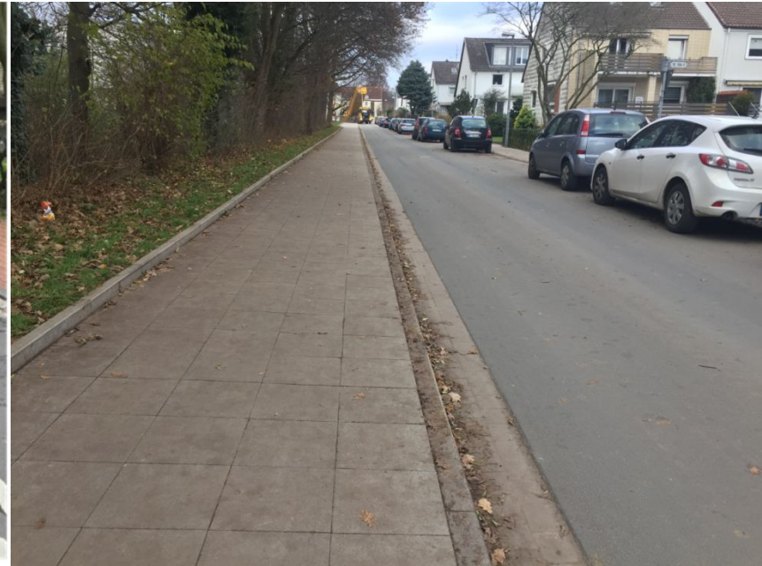
Zustand nach der Erneuerung
