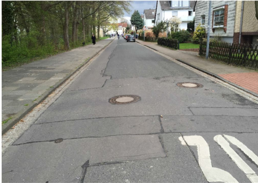
Zustand vor der Erneuerung
