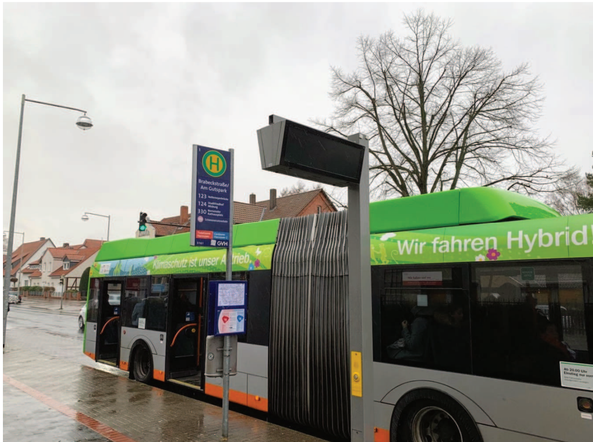
Derzeitiger Zustand der elektronischen Anzeigetafel an der Haltestelle „Brabeckstraße“: Außer Betrieb.
