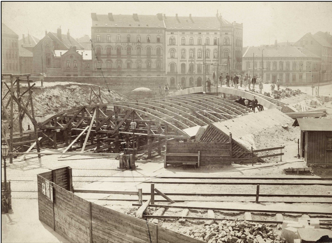
Aufnahme um 1878: Bau der Brücke über die Königstraße
