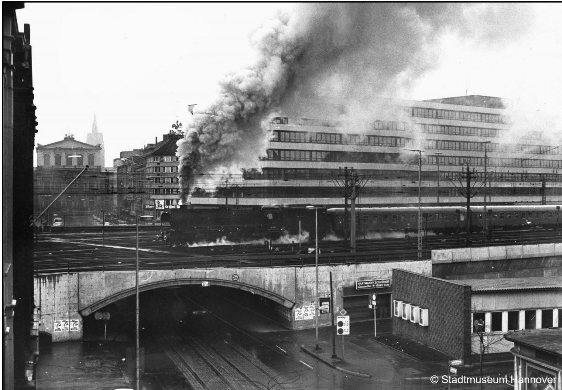
Aufnahme aus den 70er Jahren: Königstraße mit Eisenbahnüberführung, Ansicht des Nordportals, erbaut 1970,
