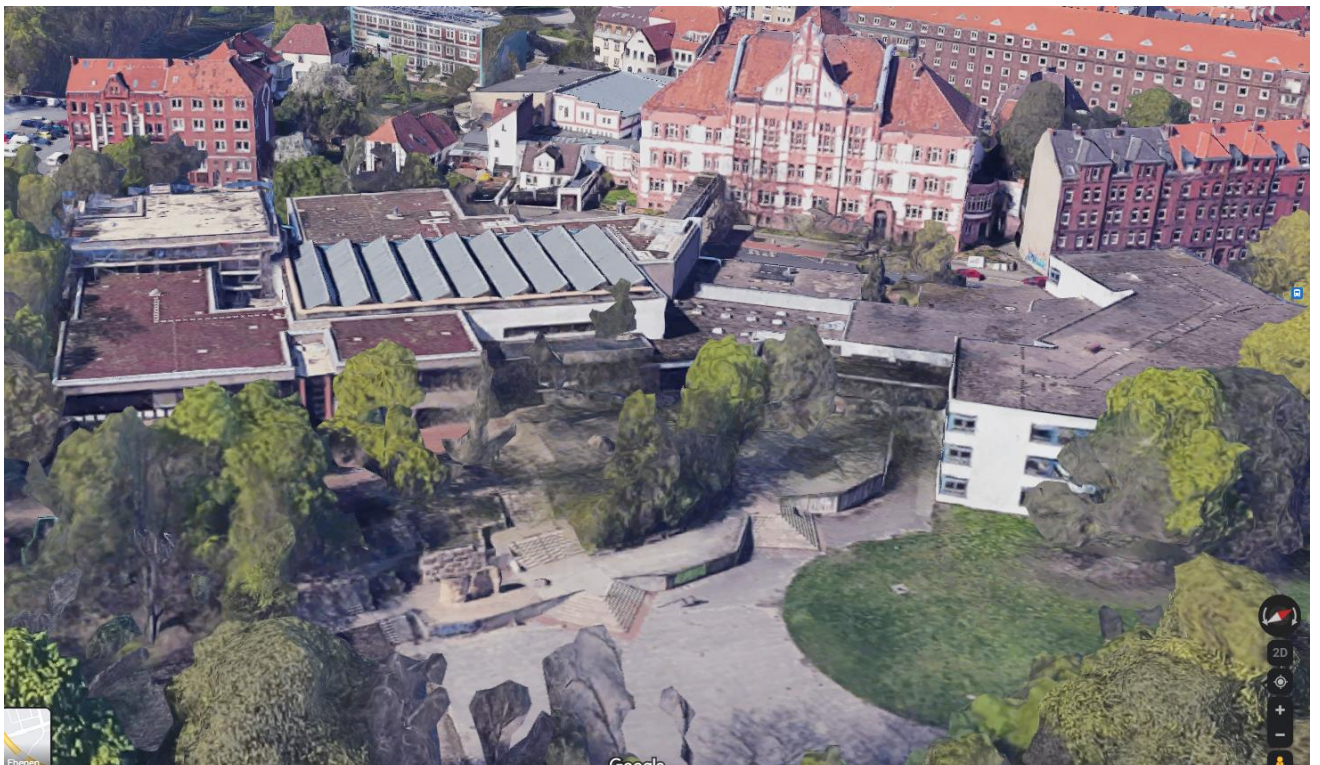
Sanierte Gründächer Hauptgebäude
