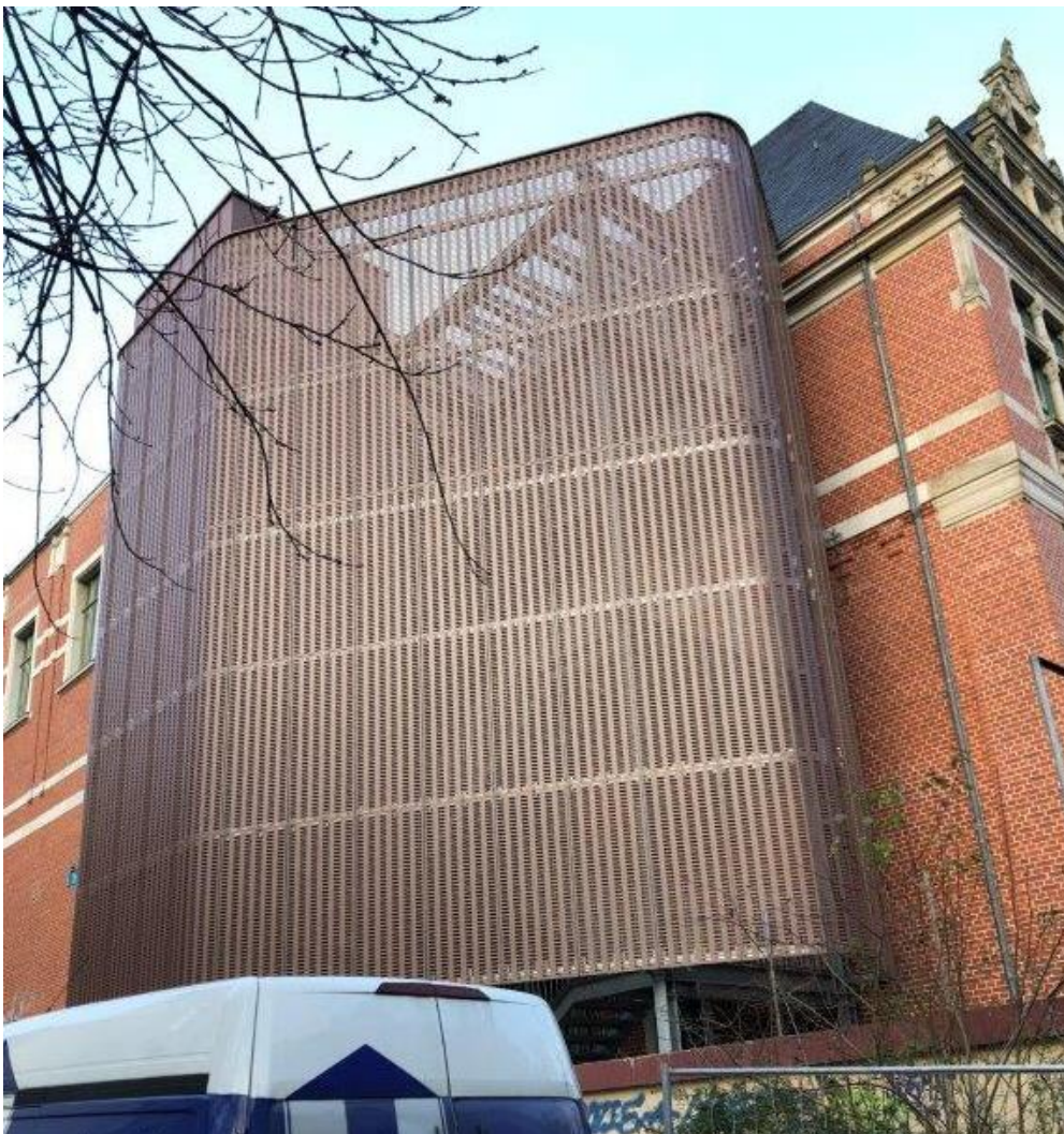
Fluchttreppenhaus auf der Südseite des Vorderhauses
