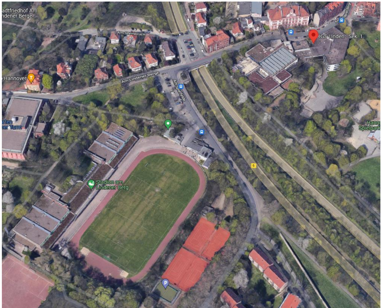
IGS Linden, Hauptstelle Am Lindener Berge 11 und 12: Altbau, Hauptgebäude und Sporthallen
