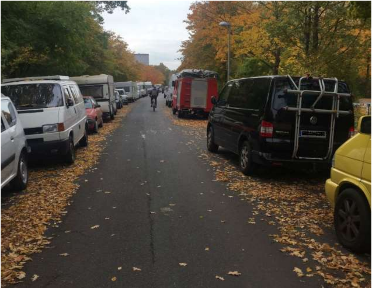
Abb. 1: Der enge Straßenraum erlaubt höchstens die Begegnung zwischen zwei Radfahrenden. Ein nebeneinanderfahren, wie es in Fahrradstraßen grundsätzlich gestattet ist, ist so unmöglich.
