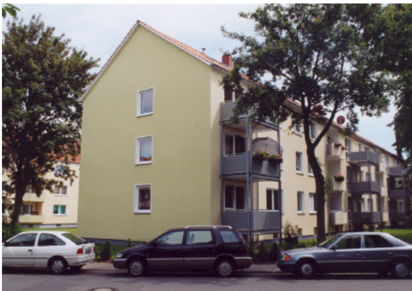
modernisiertes Gebäude in der Bömelburgstraße
