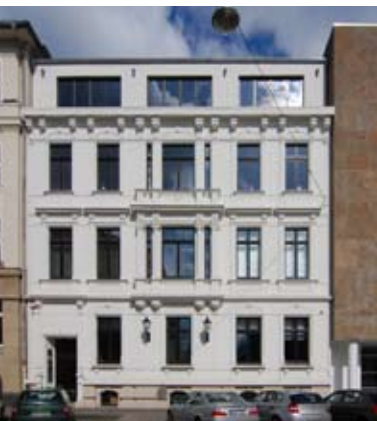
Gebäudesanierung mit Dachaufbau für innerstädtisches Wohnen
