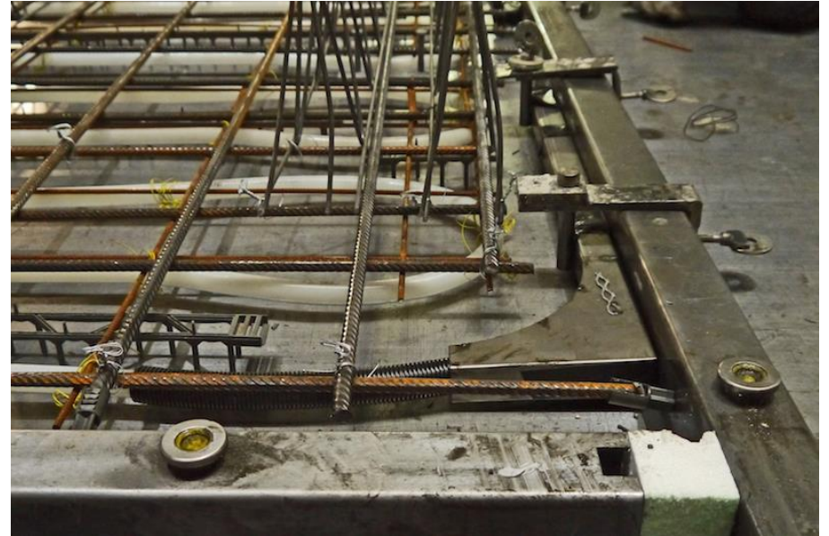
Schaltisch mit eingelegten Rohrschlangen
