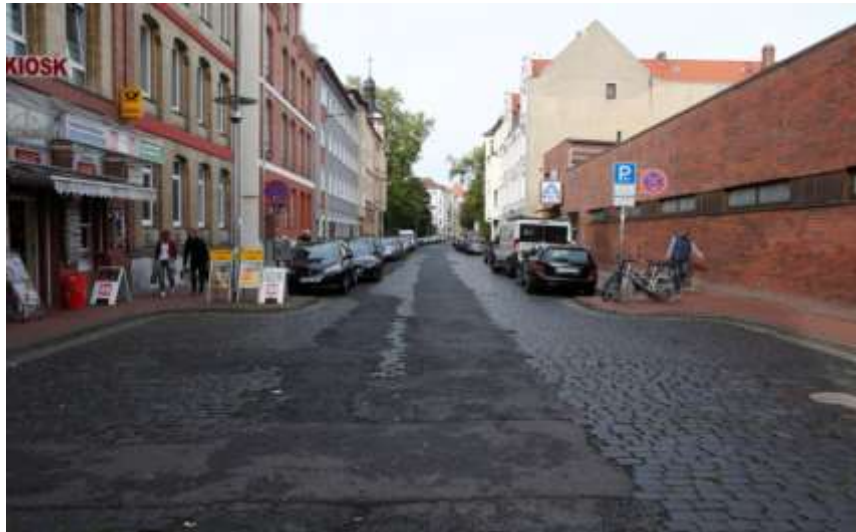
Zustand vor der Erneuerung
