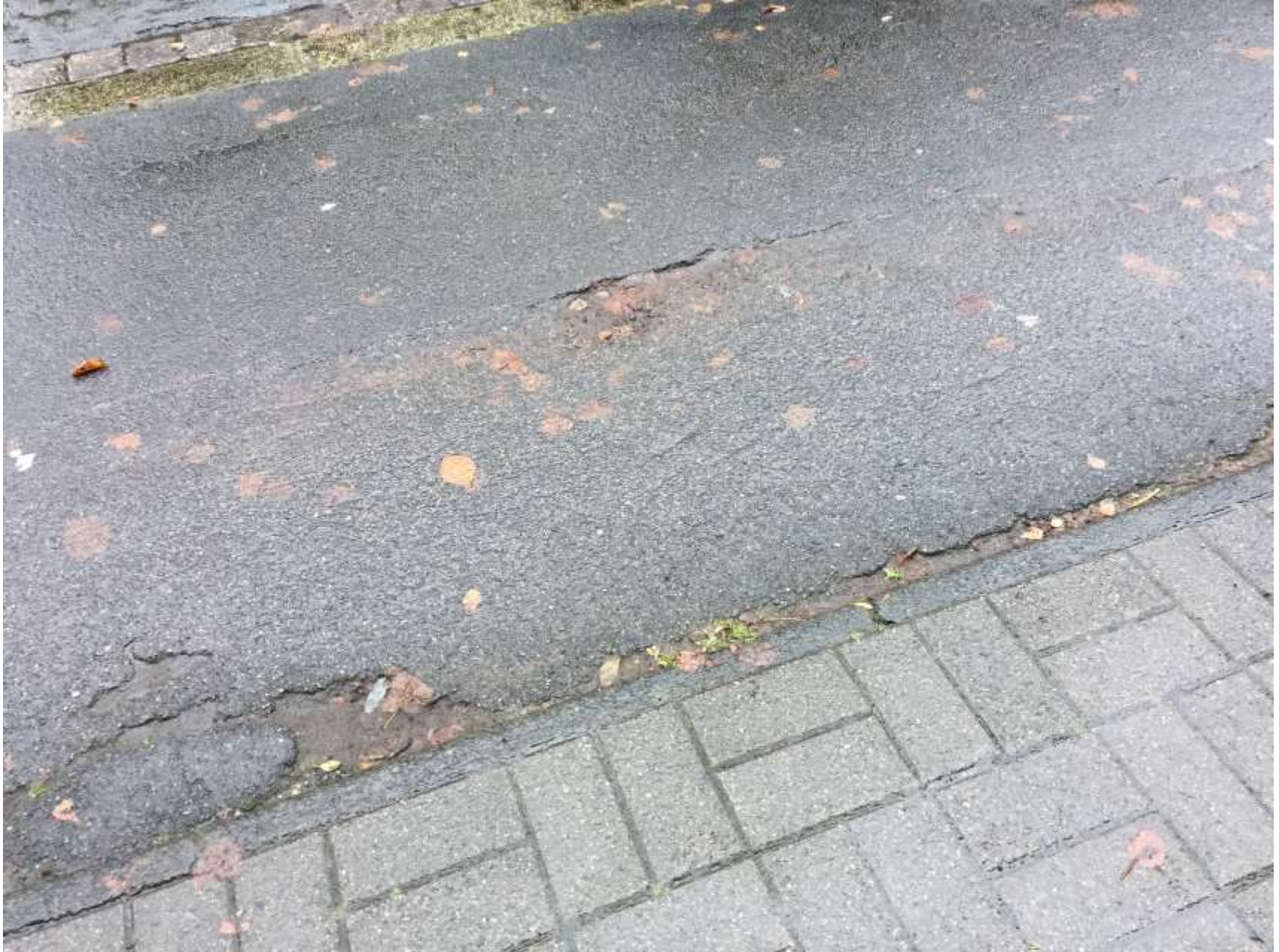
GiB Nebenanlage Wöhlerstraße
