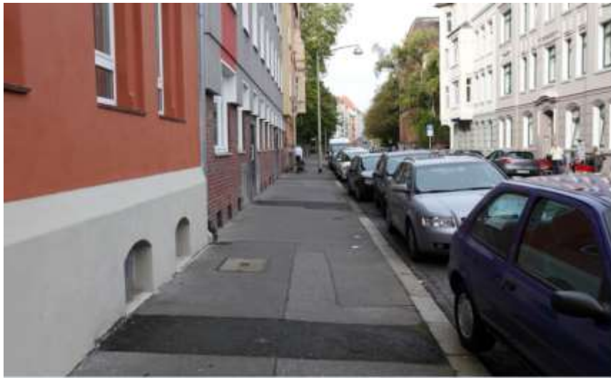
Zustand vor der Erneuerung
