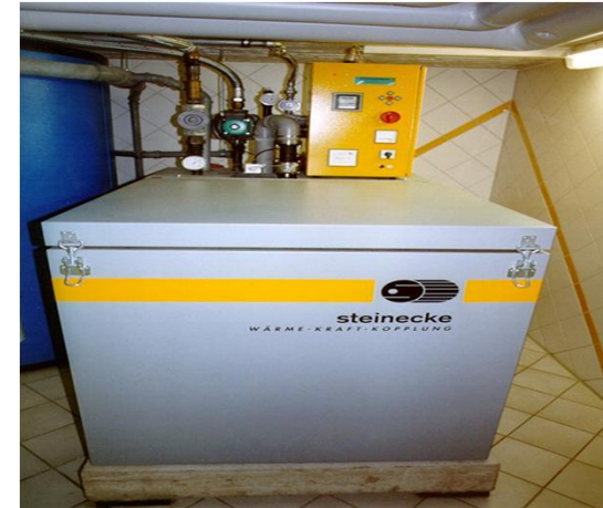
Blockheizkraftwerk (BHKW)
