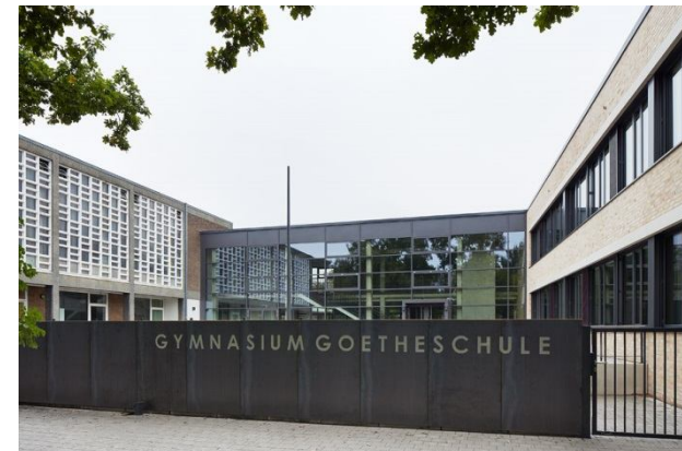
Neubau und Sanierung GY Goetheschule Foto: Copyright © Stephan Baumann (www.bild-raum.com)
