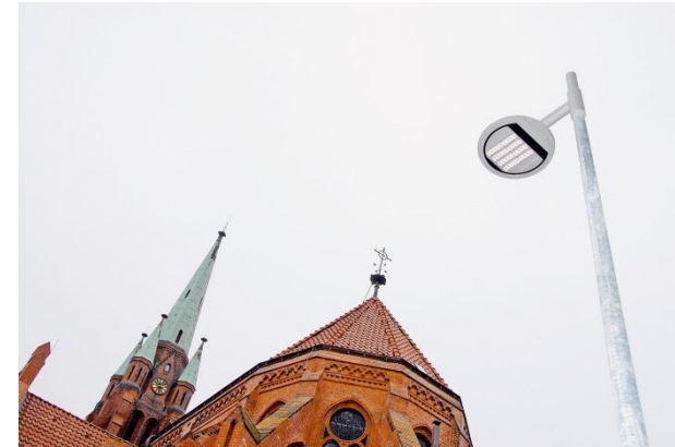
Straßenbeleuchtung mit LED
