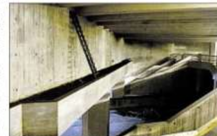
HALTESTELLE DA, STRECKE FEHLT: Die Geisterstation für die Linie 10 unterm Hauptbahnhof.
