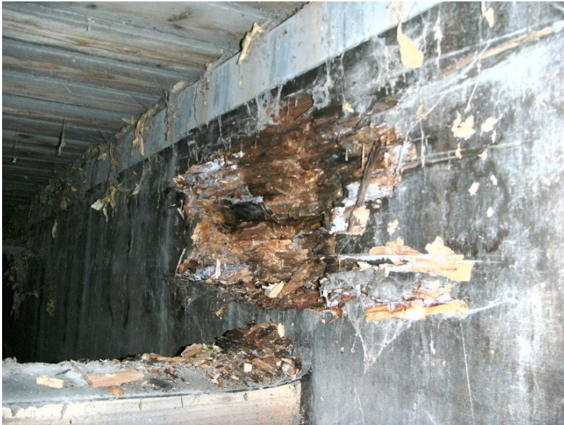
Fäule der Brettschichtholzträger bis zu 10 cm Tiefe
