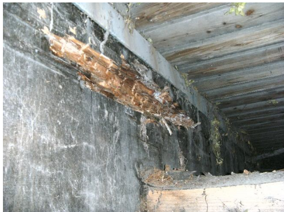
Fäule der Brettschichtholzträger bis zu 10 cm Tiefe
