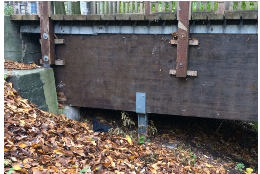
Versagende Gründung und Fäule der Auflagerbereiche
