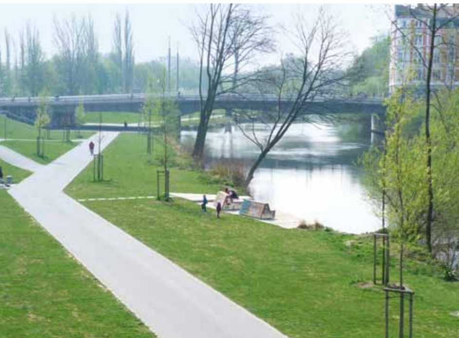
Abb. 13: Mit dem Neubau der Benno-Ohnesorg-Brücke ist der Abflussquerschnitt um 21 Meter vergrößert worden. (Foto: FB Umwelt und Stadtgrün, LHH)
