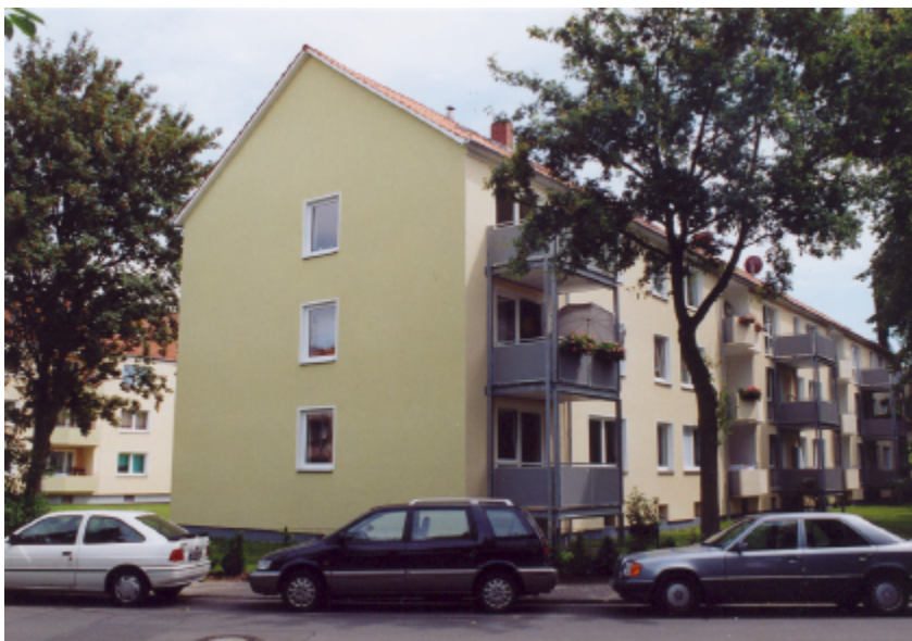
modernisiertes Gebäude in der Bömelburgstraße
